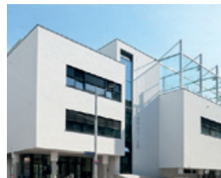
Wien 15., BG/BRG Diefenbachgasse
